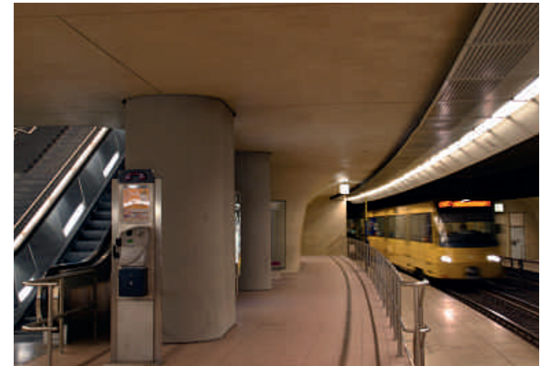
Mitte und rechts | Unter dem Schlossplatz biegt der Stadtbahntunnel von der Königstraße in die Planie zum Charlottenplatz ab. Deshalb liegt die Haltestelle Schlossplatz (Architekt Behnisch & Partner) im Radius. Bei ihrer Gestaltung wurde die Form als Gewölbe bewusst betont. Beide Aufnahmen zeigen den Blick vom Haltestellenbereich Richtung Altes Schloss.
