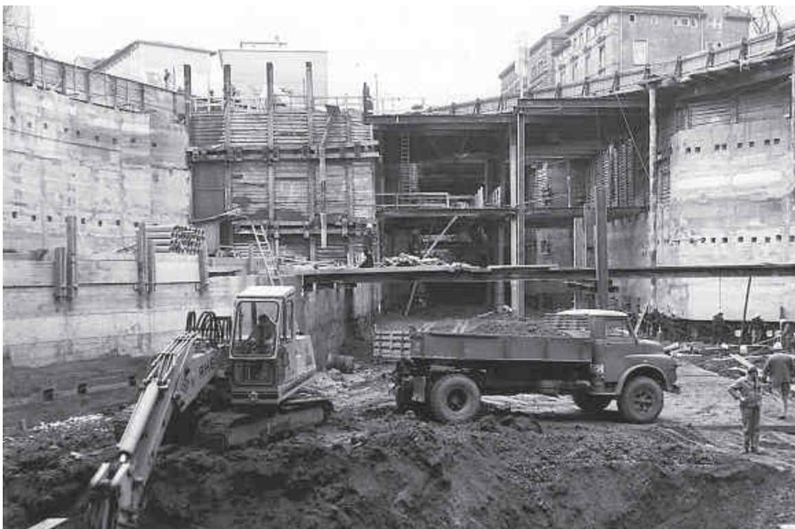
Links | Die Baugrube für die Haltestelle Neckartor, April 1970, Blick gegen Süden. Die Konturen des künftigen Bahnsteigbereiches sind hinter dem Lkw bereits erkennbar. Auch hier musste der laufende Straßenbahnverkehr in dieser Zeit provisorisch auf einer steilen Strecke über den Kernerplatz geführt werden, durch die Landhaus- und Urbanstraße.
