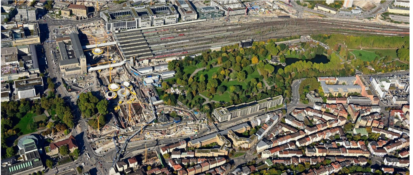
Baustelle des Durchgangsbahnhofs Stuttgart (Oktober 2019)
