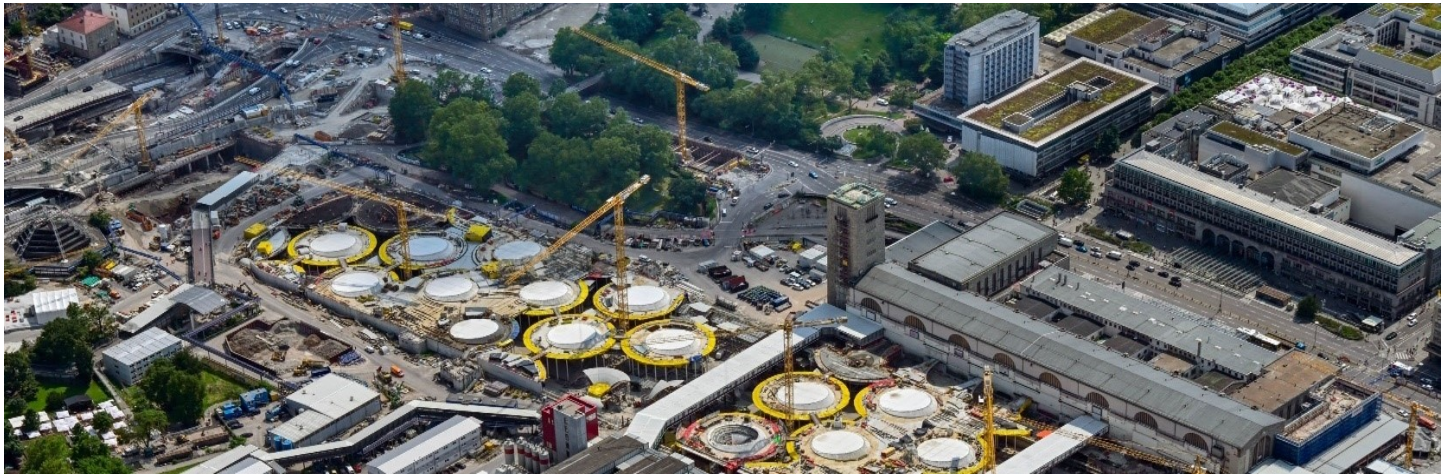
Baustelle des Durchgangsbahnhofs Stuttgart (Juli 2021)
