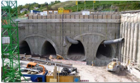
PFA 1.5 Tunnel Bad Cannstatt Vortrieb 3.176m
