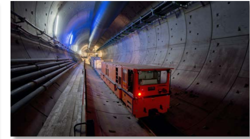
PFA 1.2 Fildertunnel Anlieferung Tübbinge Vortrieb 3.950 m
