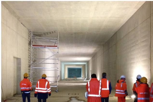
PFA 1.5 S-Bahn - Engstelle Erstes Teilstück Rohbau fertiggestellt
