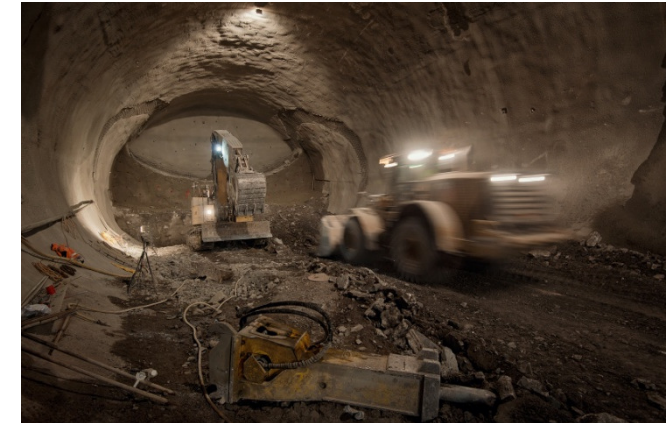
PFA 1.6a Zwischenangriff Ulmer Straße Ende Zugangsstollen bei TM 104,90 auch in Strosse/Sohle erreicht
