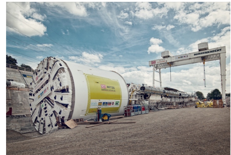
PFA 1.2 Fildertunnel: Aufbau TVM 150 Tunnelmeter
