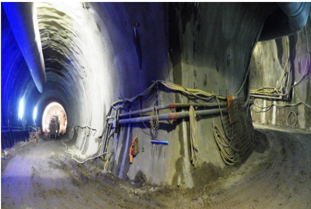
PFA 1.5 Zwischenangriff Nord Vortrieb 300 Tunnelmeter (in beide Richtungen)
