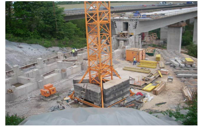
PFA 1.4 Sulzbachtalbrücke Rückbau Taktanlage Widerlager Achse 10
