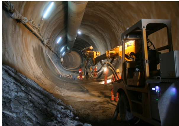
PFA 1.2 Rettungszufahrt Wagenburg Vortrieb fertig gestellt, Restarbeiten laufen 166 Tunnelmeter
