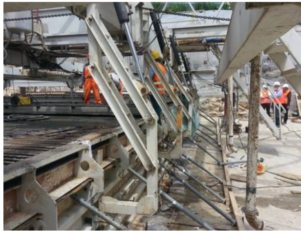
PFA 2.3 Tunnel Widderstall Beginn Innenschale
